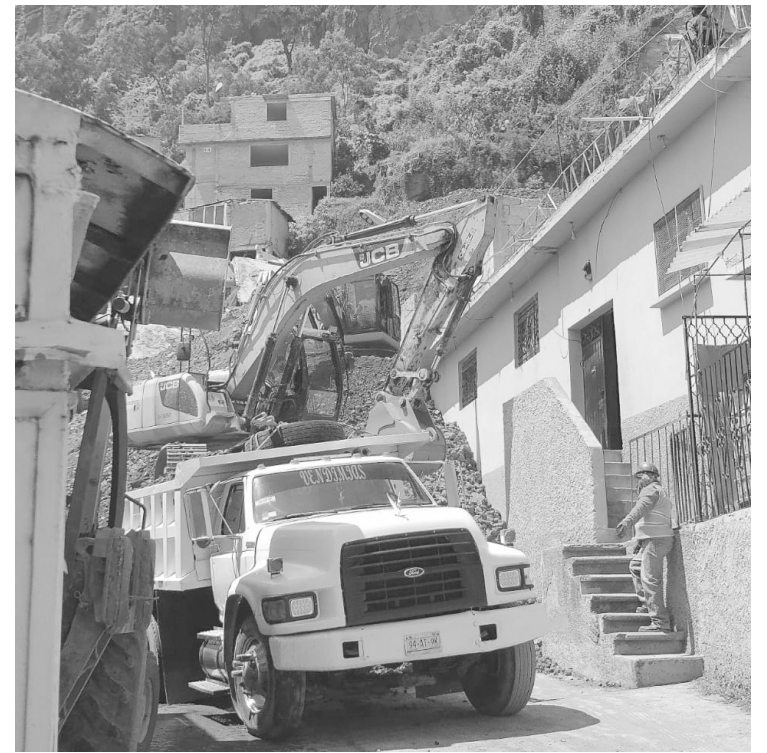
▲ Maquinaria pesada descarga el material y efectúa los trabajos de adecuación. Foto especial
